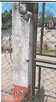
Foto 5: las columnas del muro presentan deterioro
