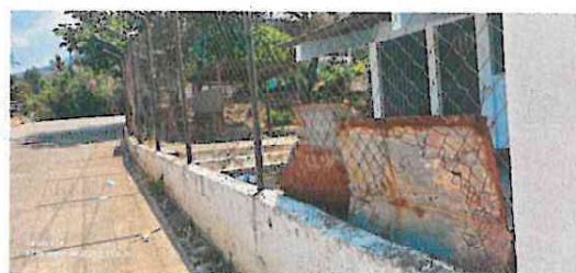
Foto 6: la maya desprendida de las bases de block en el muro perimetral.
